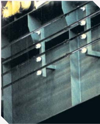
Instalación de carriles con pie de acero y cabeza de cobre en siderurgia, tensión de alimentación 6 KV.
